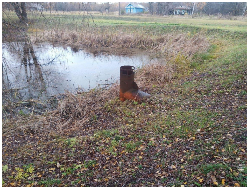
Фото 10. Водопропускная шахта трубы №1
